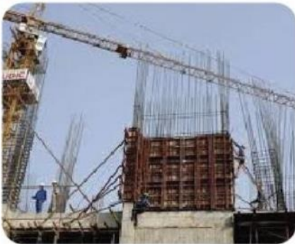
THI CÔNG CÔNG TRƯỜNG
