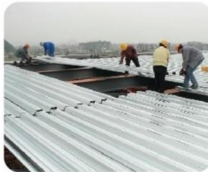
THI CÔNG MÁI TÔN
